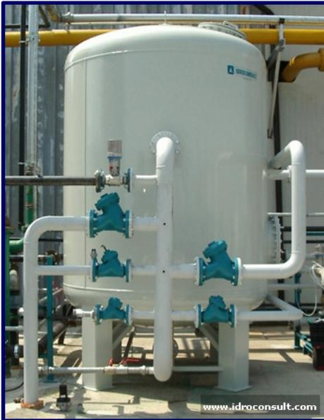
Impiegata comunemente per la rimozione di ferro e manganese, in un processo che prevede più fasi:
